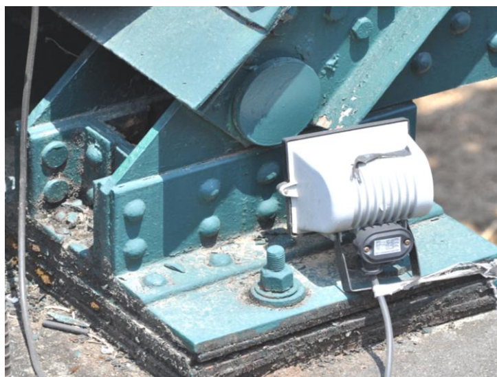
รูปที่ 1.6 แสดงฐานรองรับแบบยึดหมุนเคลื่อนที่ไม่ได้ (Hinge Supports)
