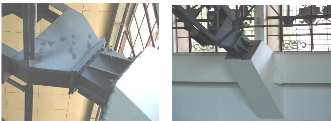
รูปที่ 1.8 แสดงฐานรองรับแบบยึดแน่น (Fixed Supports)
