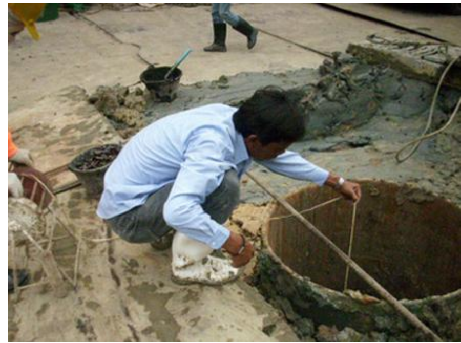
ข.หลุมเสาเข็มเจาะขนาดใหญ่
