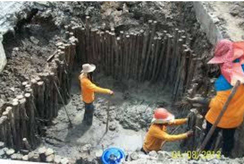
ก. กำแพงกันดินเสาเข็มไม้
