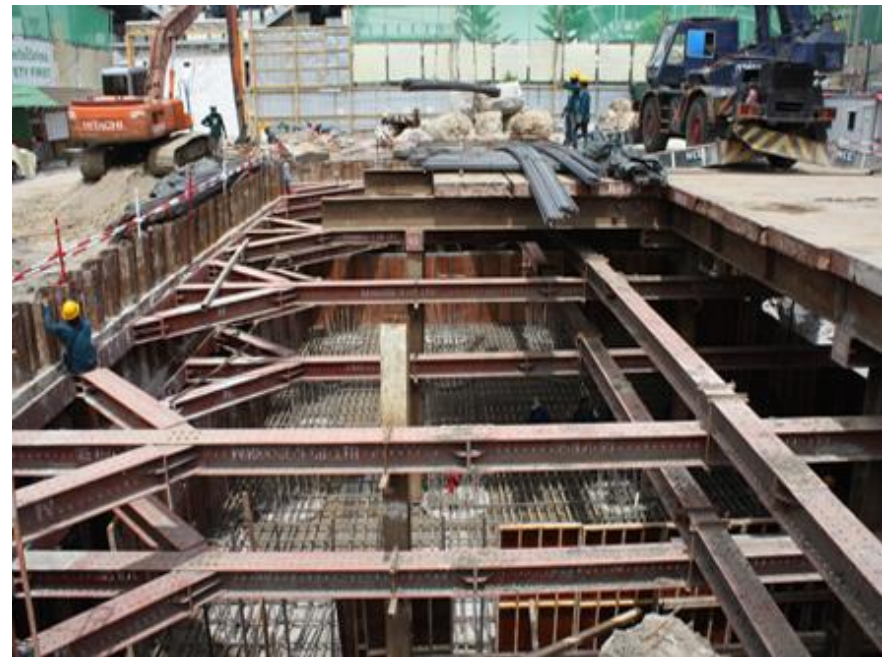
ข. กำแพงกันดินเสาเข็มเหล็ก และค้ำยัน
