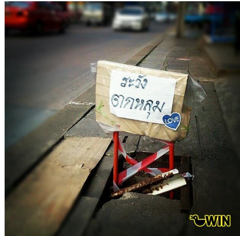
ข. ติดป้ายเตือน
