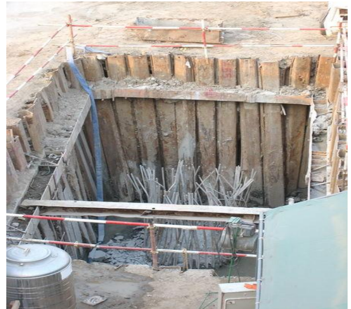
ข.หลุมฐานรากมีกำแพงกันดิน
